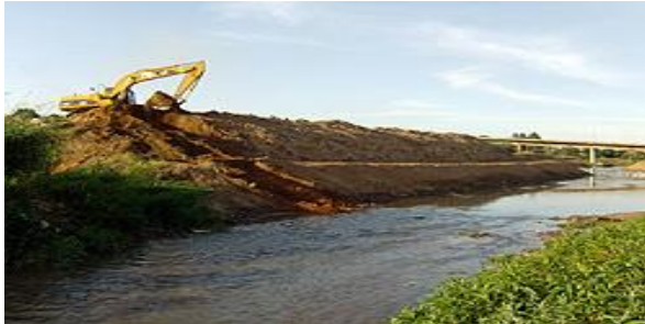
Figura Ribeirão Jacuba em ampliação da margem
