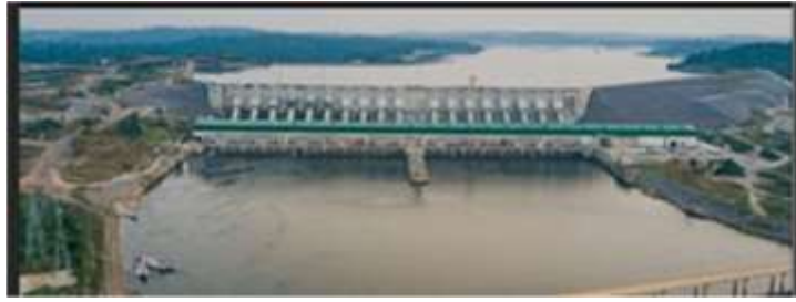
Usina Elétrica de Belo Monte
