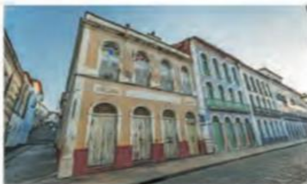
Conjunto de casas coloniais no centro histórico do município de São Luís, estado do Maranhão, 2015.
