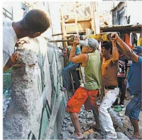
Moradores derrubam muro na favela do Moinho, no centro
